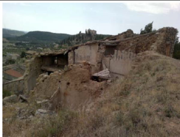
Estado de las parcelas desde la calle superior.
