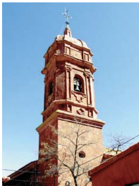
Torre de la iglesia de Peracense, obra singular en piedra de rodeneo
