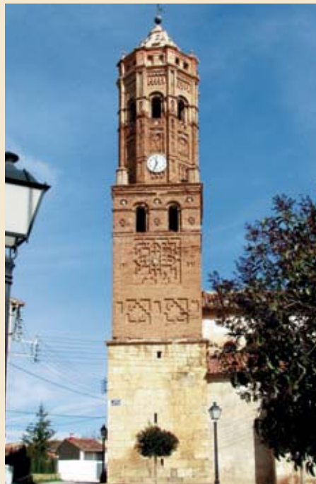
Torre de Navarrete del Río
