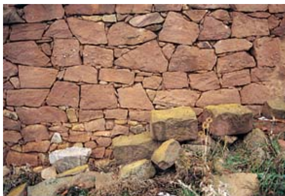
Piedra de rodano, bien aparejada, en un muro de Peracense
