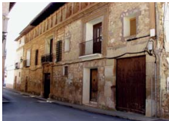
Casa de los Mateo de Gilbert, en Monreal del Campo
