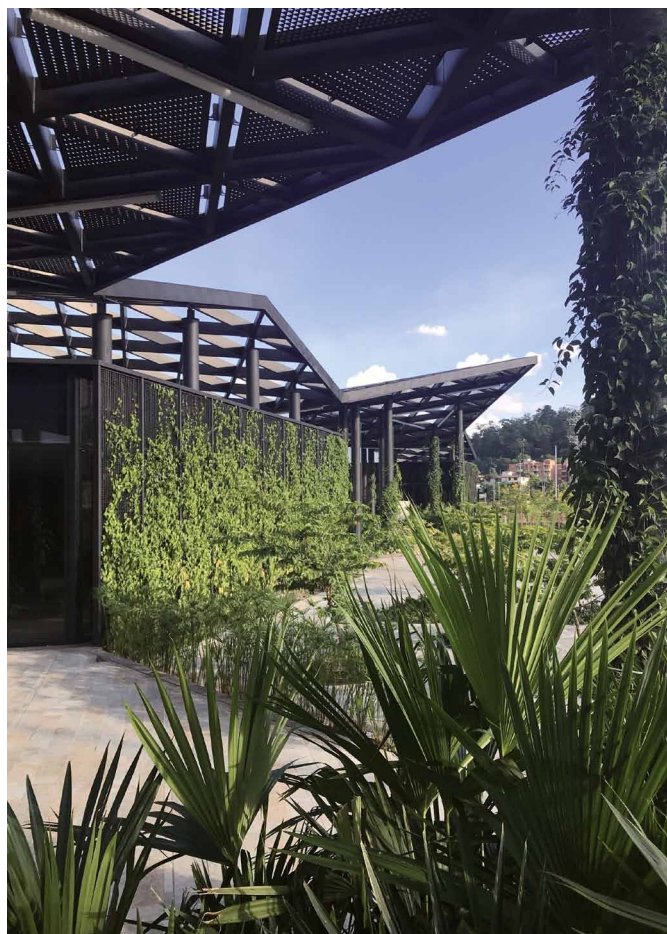
FIG. 8/ El sistema de pérgolas y las paredes verdes de los quioscos.
